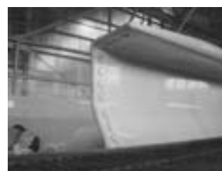
図10 改良したZ形遮音板の端部形状
