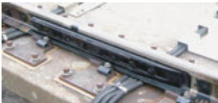
図8 接着絶縁継目
