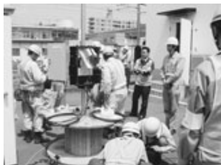
図9 施工性確認の風景
