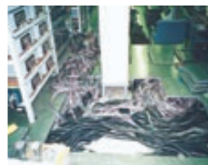
写真1 機器室の信号ケーブル敷設
