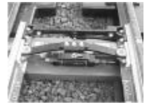
図5：転てつ付属装置類をまくらぎ直上に配置
