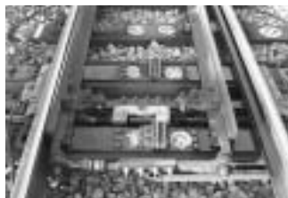
図3：現行の転換付属装置類
