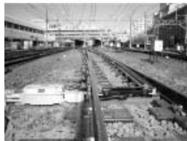
図17：敷設後の次世代分岐器・転てつ機(大宮駅構内80イ)
