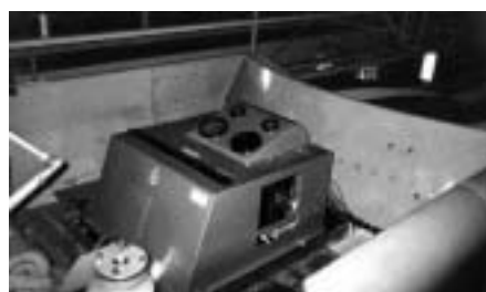
図7：装置仮設状況
