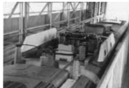
図5：装置仮設状況
