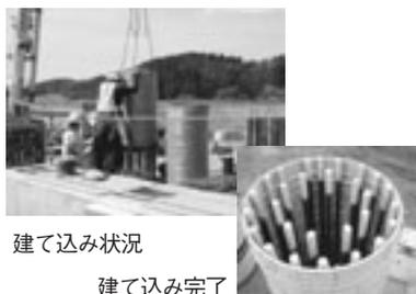
図15 スパイラル筋建て込み
