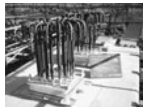
図22 モルタル打設完了
