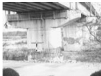
図1 橋脚段落し部の被害状況
