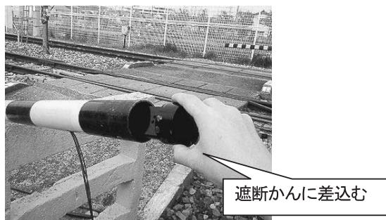
図13 遮断かん折損検知装置の取付方法
