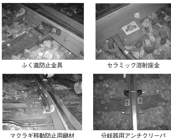
図9 特殊分岐器設備故障対策（装置化）の例
