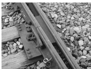
図15 ポイント後端継目
