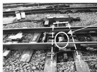
図14 モーター付マクラギ部
