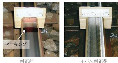
図9 レール削正前後の頭頂面
