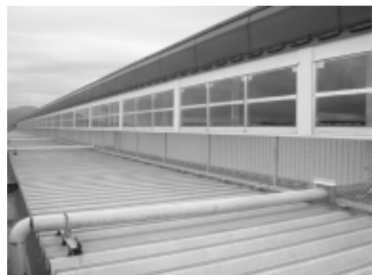
図16 I 駅改修後写真 (下り線側開口部付近 駅舎外部より)
