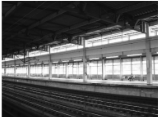
図17 I 駅改修後写真（下り線側開口部付近 駅舎内部より） とにした。
