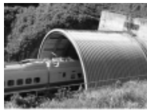
図1 トンネル緩衝工
