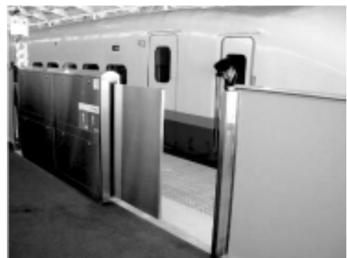
図7 ホーム柵の一例 (可動式)
