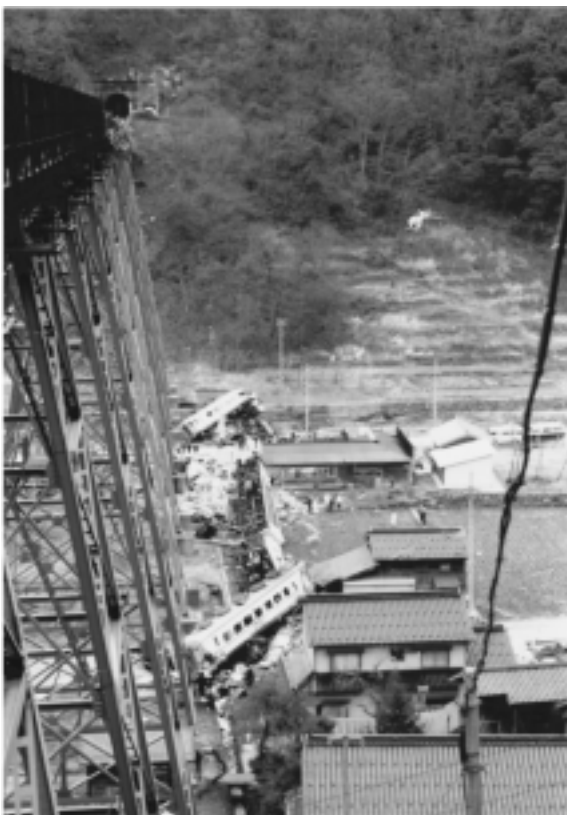
図1 山陰本線余部橋りょう事故写真-1
