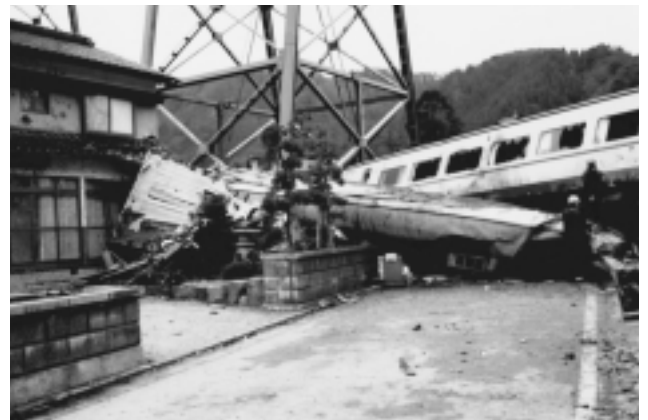
図2 山陰本線余部橋りょう事故写真-2
