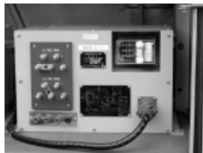
図3 交直架線電流検知装置（電源部）
