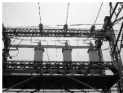
図2 交直架線電流検知装置（検知部）
