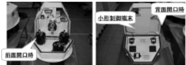
図7 入換信号機への実装状況
