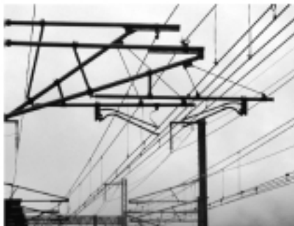
図10：オーバーラップ構成図と実際の設備
