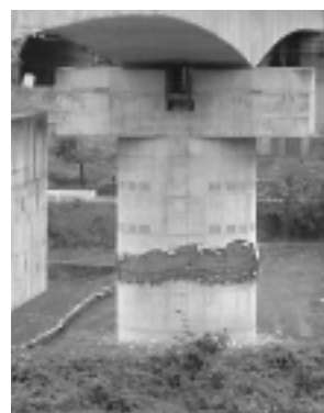
図1：橋脚の途中定着部の損傷状況
