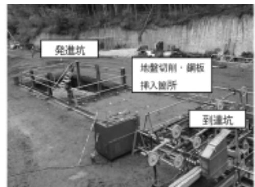
図10：試験箇所の状況
