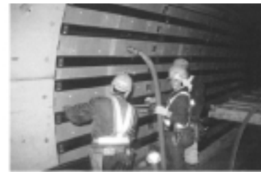
図15: 裏込めモルタル打設
