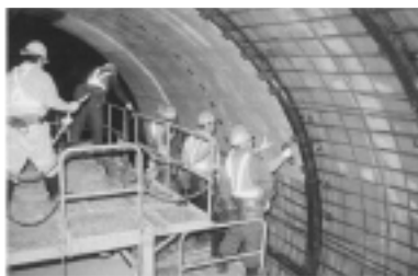
図13: 繊維補強セメントパネル設置
