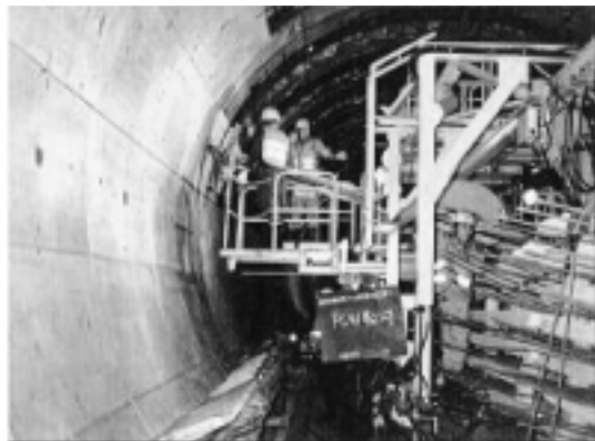
図6：エレクターによるPCW工法の施工
