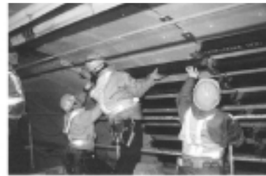
図14: 仮設梁取り付け
