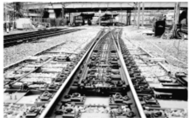
図1：敷設された一期試作品（大崎駅構内）
