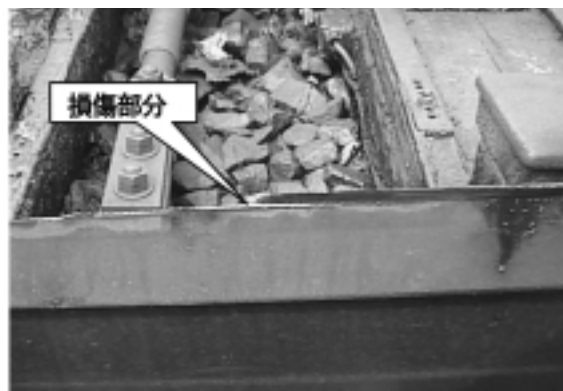
図11：トングレール先端に発生した水平裂
