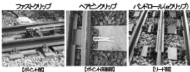
図5：導入した各種レール締結装置
