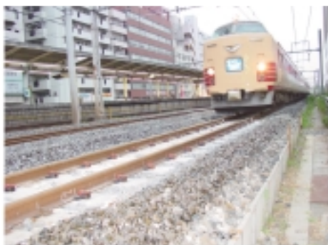
図20：営業線に敷設した試験軌道
