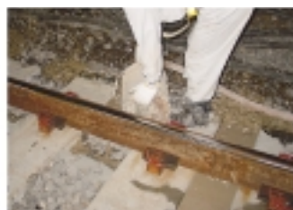
図9：TC型省力化軌道の施工手順
