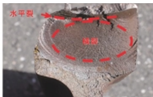
図6：レール内部へ進展したき裂
