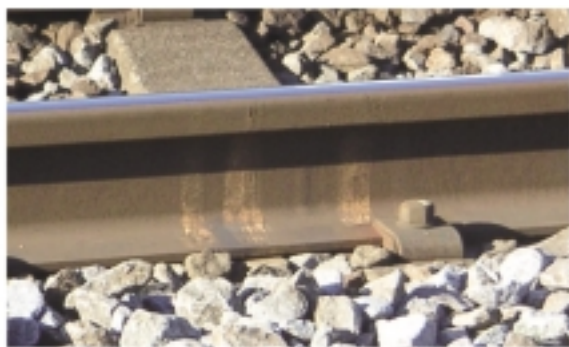
図2：レール溶接部の外観（横から）
