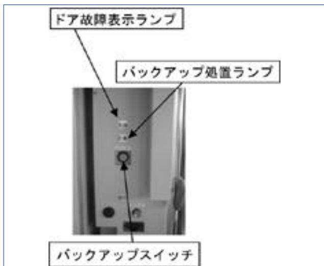
図10：バックアップ操作盤
