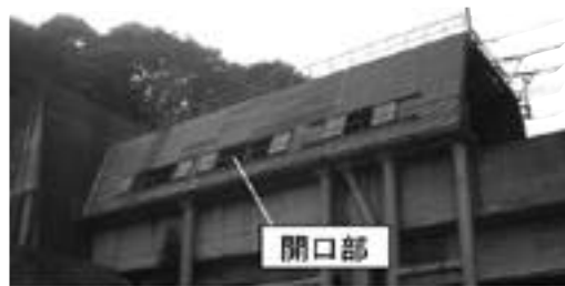
図2：トンネル入口緩衝工
