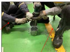
動力攪拌を行う作業員
