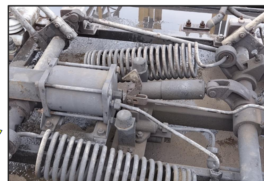
平場、ホーム上から屋根上状態の詳細な確認、点検が可能
