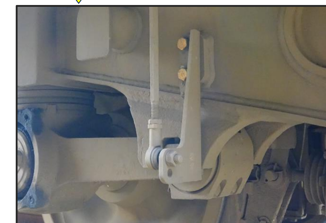
ホーム上からホーム側床下の点検も可能
