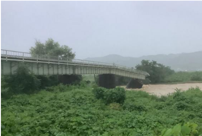
磐越西線 喜多方～山都駅間 にぎりかわ 濁川橋りょうの被害状況
