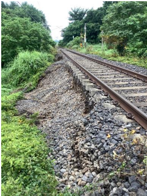
奥羽本線 置賜～高畠駅間 盛土流出 復旧作業状況
