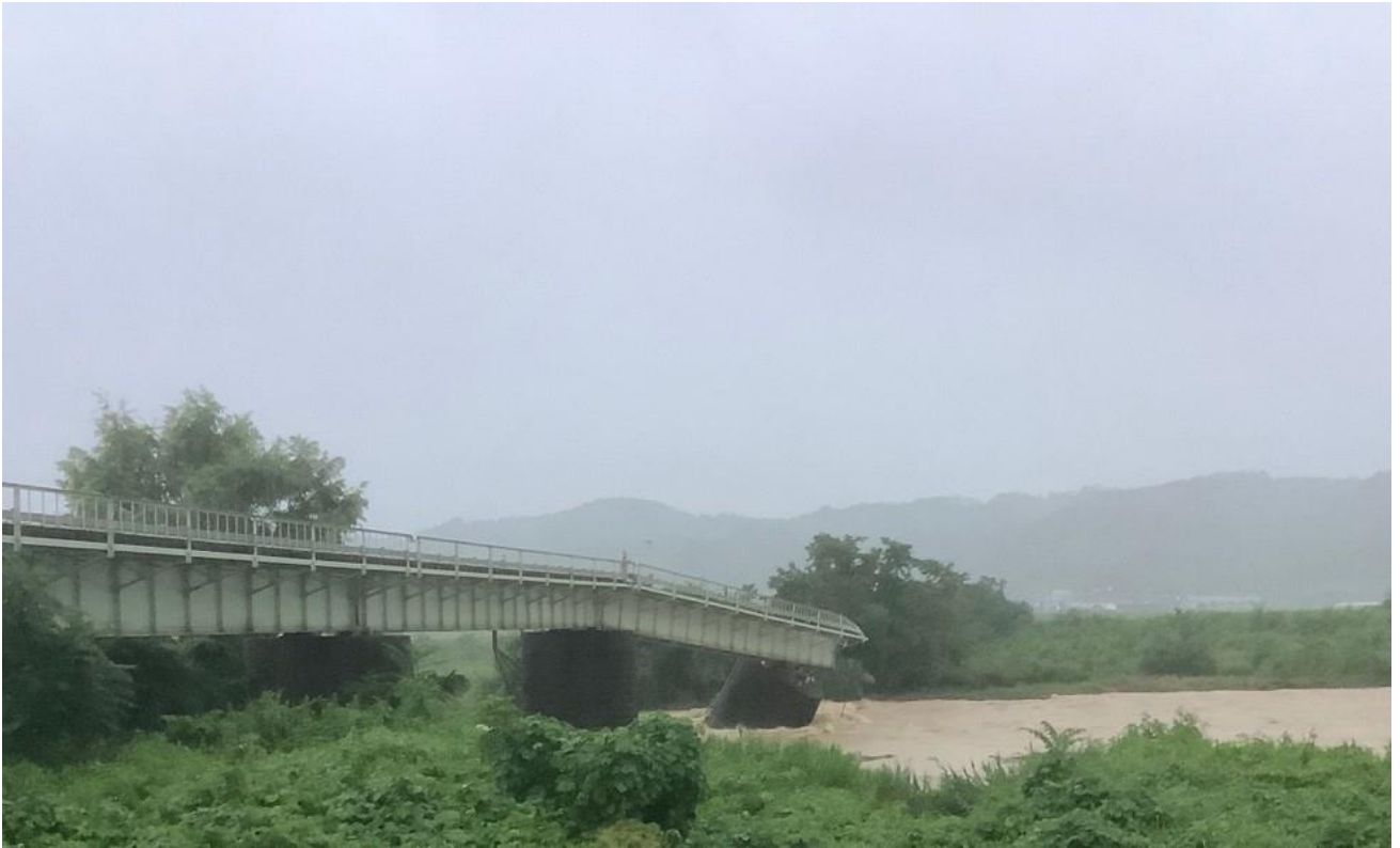
喜多方～山都間 にごりかわ 濁川橋りょう
