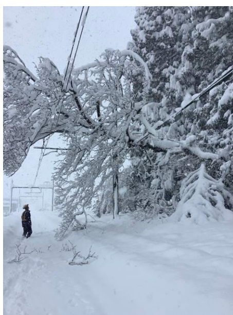
上越線 越後滝谷付近の様子
