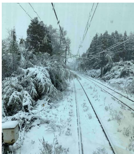
信越本線 田上駅付近倒竹の様子
