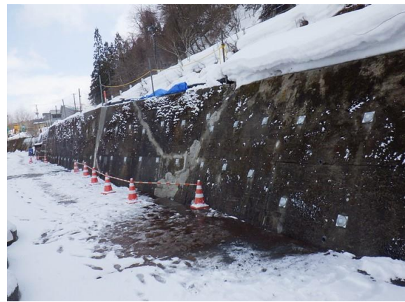
十和田南～末広駅間 米代川護岸修復状況 (2023年2月25日撮影)
