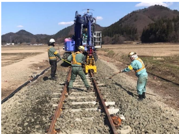
末広～土深井駅間 軌道復旧中の状況 (2023年3月28日撮影)
