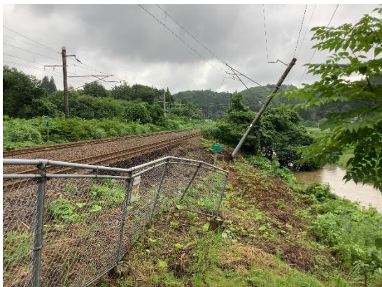
盛土流出・電化柱傾斜
