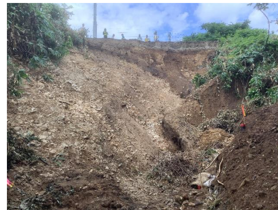
測量作業・作業ヤード設置・重機械搬入
