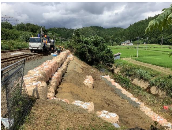
盛土施工完了
