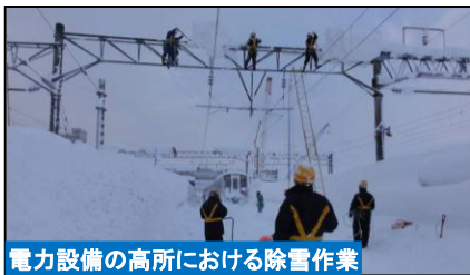
【電力設備の冠雪除去】
