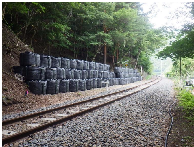
【落石対策工事の状況】
