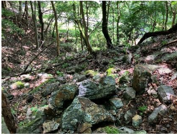
【落石が発生した斜面の全景】
