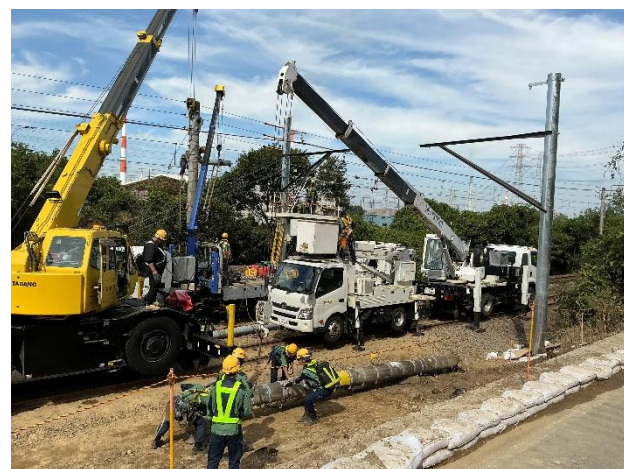
電力設備の復旧工事
