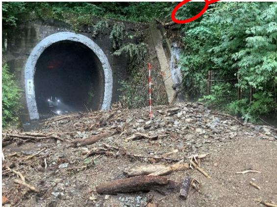
第二外山トンネル入口 土砂流入状況
