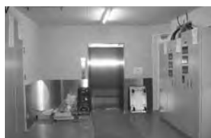
物流用エレベーター
