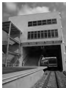
Smart Station 実験棟
