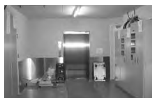
物流用エレベーター
