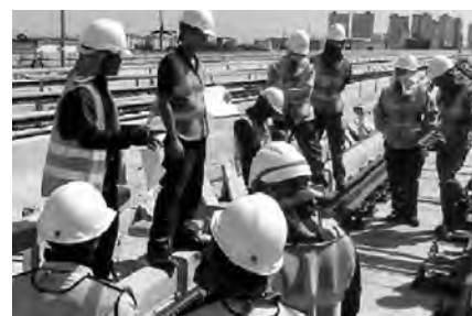
軌道メンテナンス
