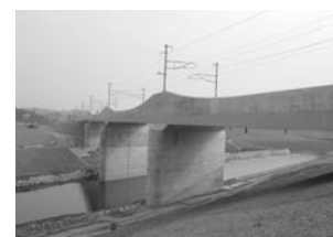
東北線平泉～前沢間衣川橋りょう
