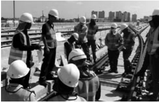
軌道メンテナンスの様子
