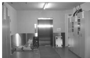
物流用エレベーター
