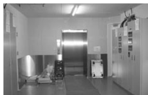
物流用エレベーター
