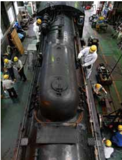
検査作業風景
