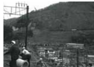
複線化工事中新潟湯檜曾信号場付近から望む湯檜曾ループ線
