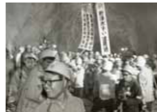
新清水トンネル貫通式
