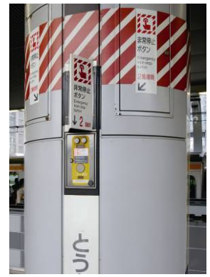
内方線付き点状ブロック 列車非常停止警報装置
