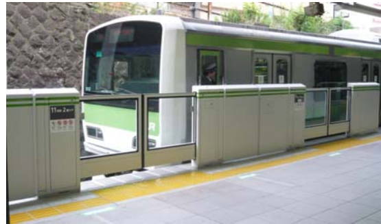
山手線ホームドア整備
