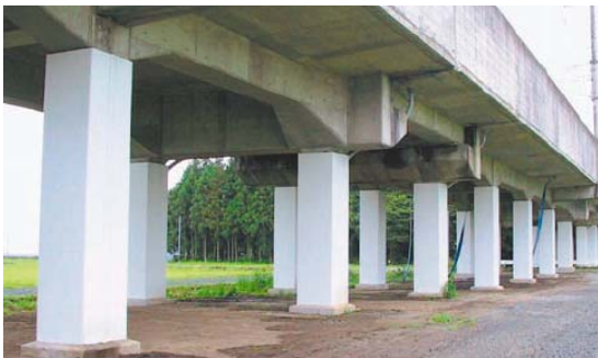
高架橋の耐震補強
