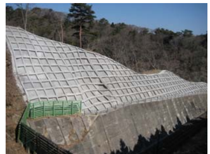
自然斜面防護工（吹付枠工）
