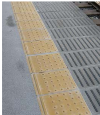
内方線付き点状ブロック 列車非常停止警報装置
