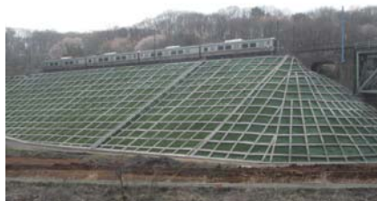
盛土のり面工（吹付枠工）
