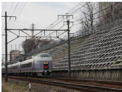
切取のり面工（吹付枠工）
