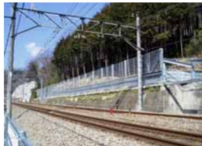
土砂止め柵 [自然斜面]
