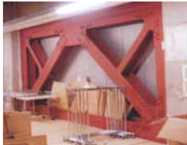
鉄骨ブレースによる補強
