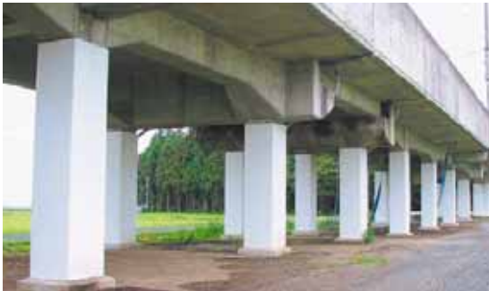
高架橋の耐震補強
