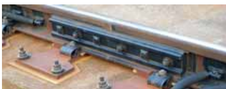
改良前の接着絶縁継目
