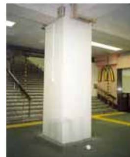
鋼板巻きによる柱の補強
