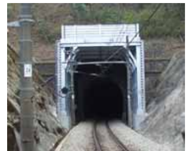
覆い工 [トンネル出入口]
