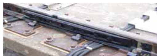
改良後の接着絶縁継目
