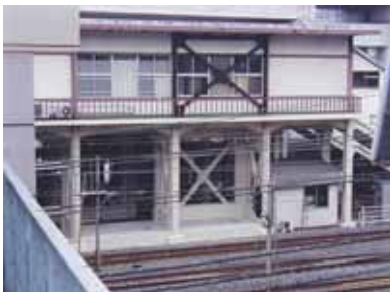
鉄骨ブレースによる補強
