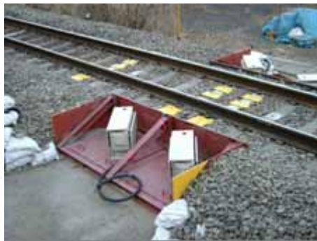
車軸軸箱温度検知装置
