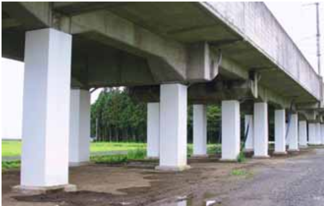
鋼板巻きによる高架橋柱の耐震補強
