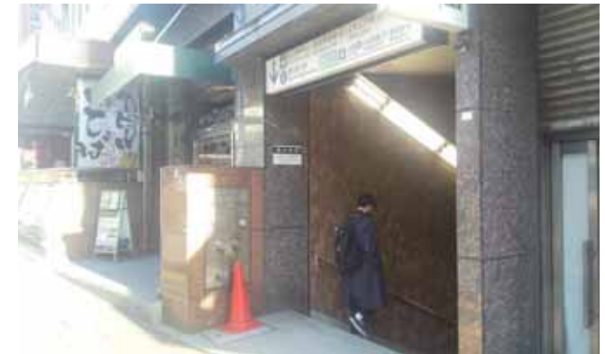
駅とまちをつなぐ歩行者動線上の段差
