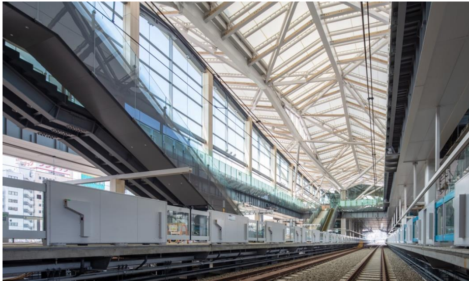
ホーム階より吹き抜け部を望む 2019年11月時点
